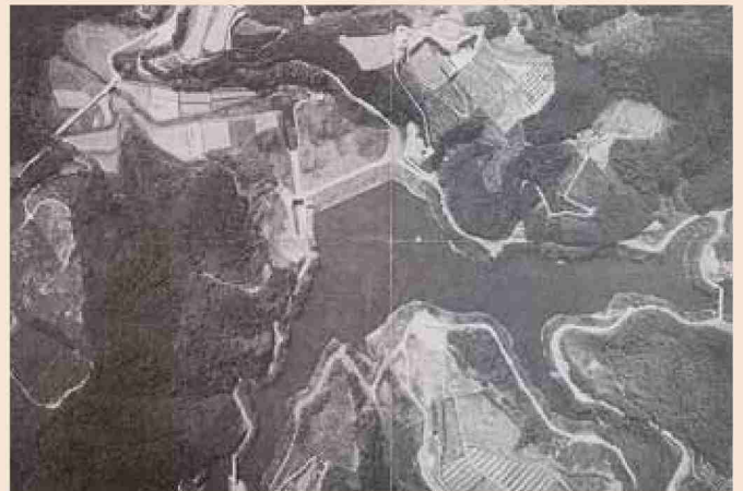
●昭和46年 広川防災ダム完成直後の写真
