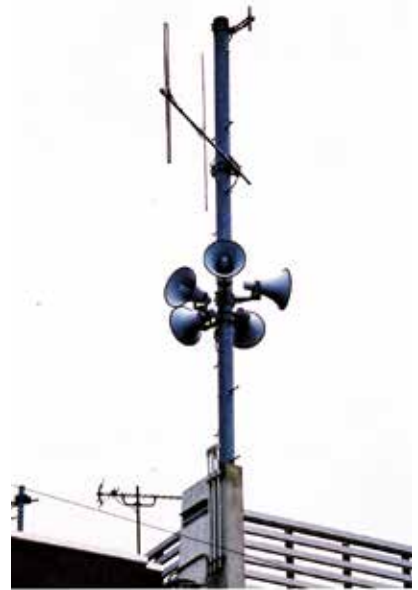
平成8年、町制施工40周年記念事業として防災行政無線が整備供用された。
