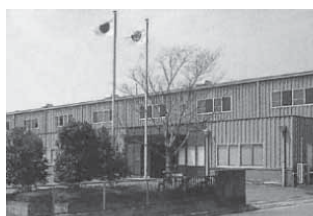
町内に九州工場、九州営業所があり、第2工場を現在建設中。
