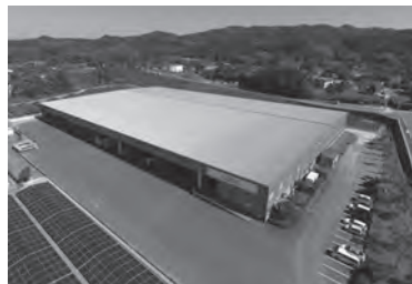
10月に完成したLIXIL 広川太陽光発電所
