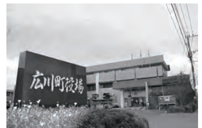
現在の本庁舎。老朽化が進み、震度6～7の地震で倒壊・崩壊する恐れがある。
