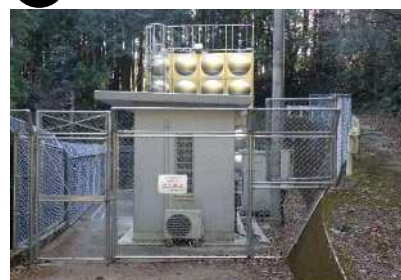
③ 鬼ノ淵配水池
