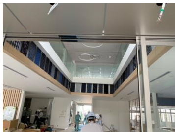
1F 吹き抜け
