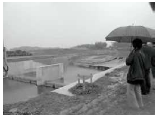
一條前川原地区転倒堰
