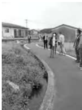
吉常下樋口地区水路改修
