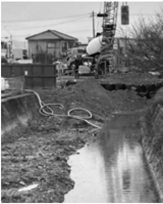
工事中の古賀地区頭首工改築工事現場
