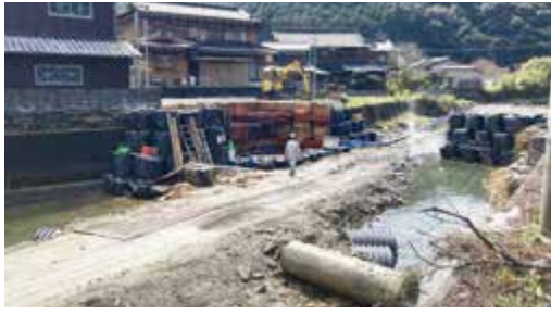
工事中の松川原橋
