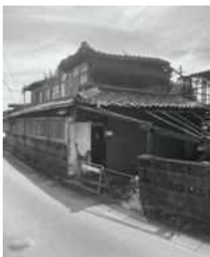
老朽化した空き家
