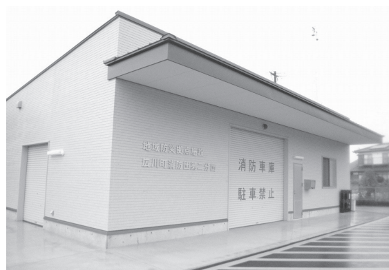
完成した第2分団詰所
