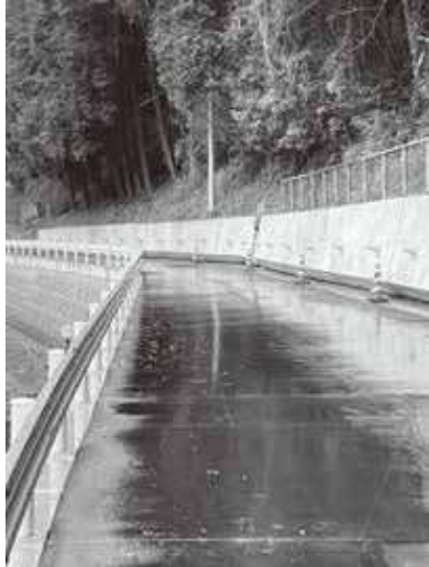
復旧した梯本線道路
