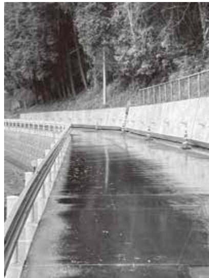
復旧した梯本線道路
