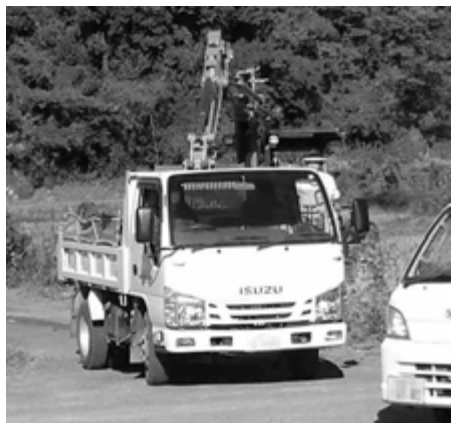
重機を利用した道路愛護
