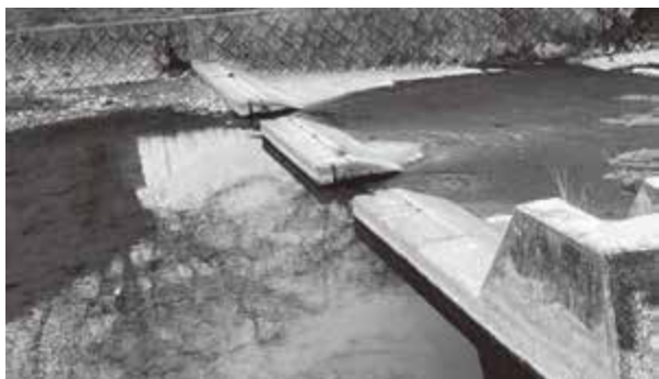
改修される古賀井ぜき
