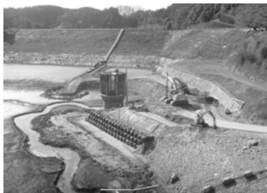
広川ダム工事の状況
