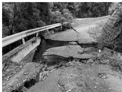
繰越明許費の工事現場 (小椎尾梯線災害復旧事業)
