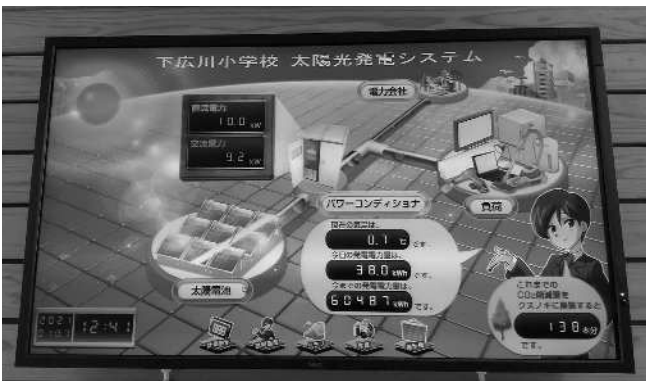
下広川小の太陽光発電システム
