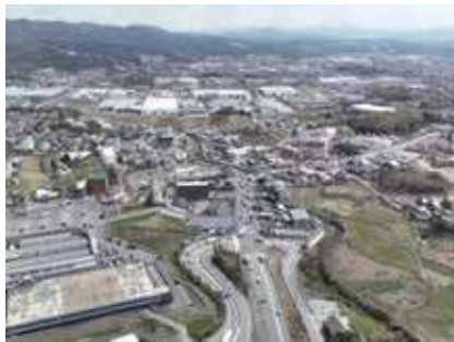
▲広川インターチェンジより八女市山間部方面を望む (掲載許可 国土交通省福岡国道事務所)
