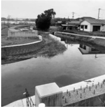
橋梁の上部工事を待つ吉里牟礼線（湯府橋）の現場
