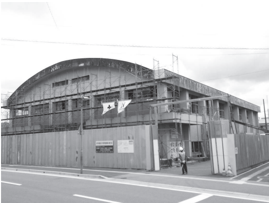
解体中の武道館
