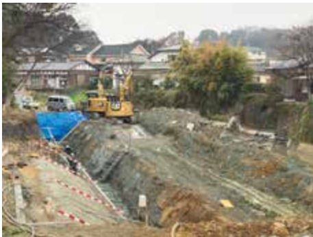
▲附島井堰撤去工事
