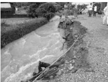
河川氾濫後の被害状況
