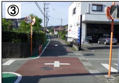
カラー舗装(グリーンパルト・段差舗装) 路肩の安全対策(ラバーポール設置)
