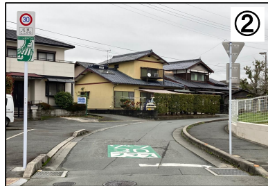
ゾーン30プラス看板・路面標示
