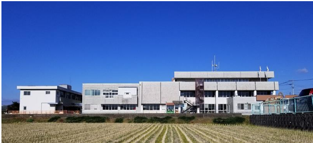
庁舎附属建物解体後の現庁舎
