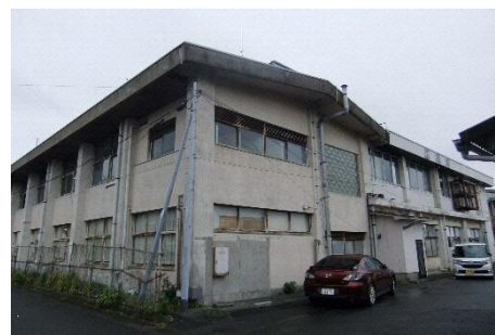
【西庁舎（旧中央公民館）】
