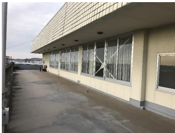
▲屋根の劣化状況
