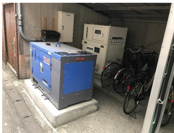
▲駐輪場に設備機器を設置している状況
