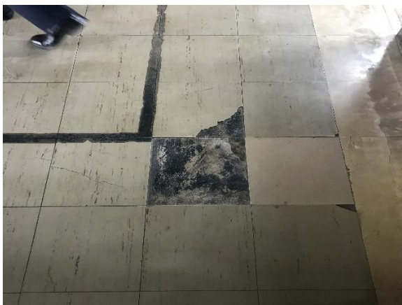
▲床仕上の剥がれ
