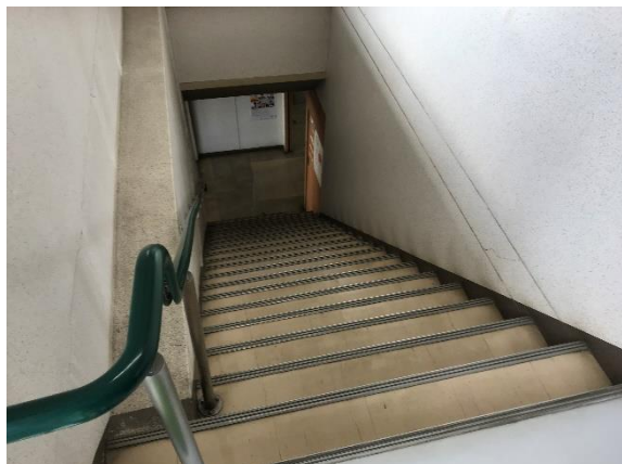
▲3階にある急勾配の階段
