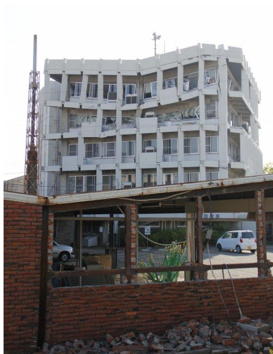
▲熊本地震で被災した宇土市役所 (写真：宇土市 HP より)
