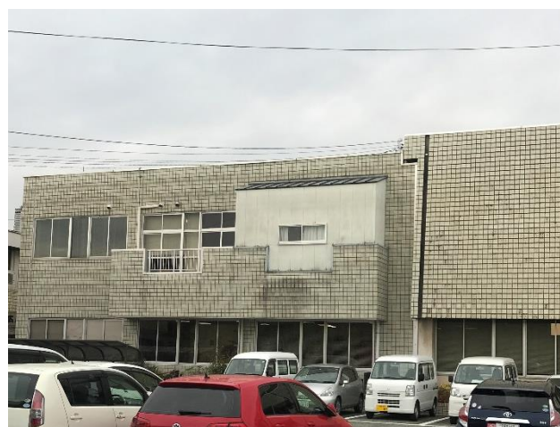
▲ 一部増築されている部
