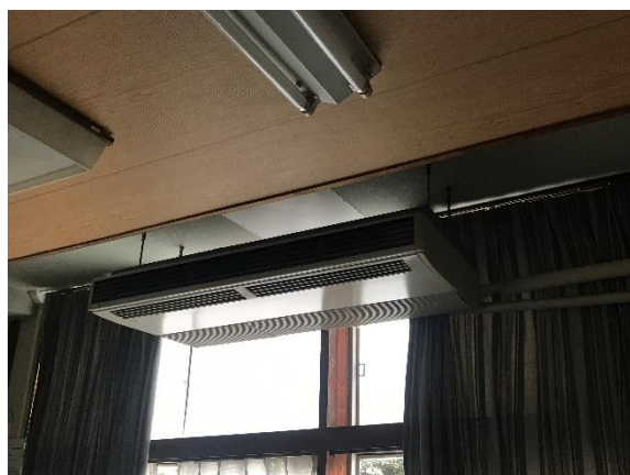
▲空調設備の老朽化
