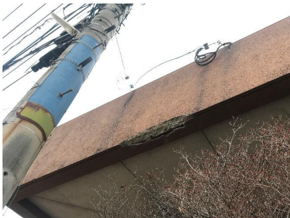
▲外壁の劣化状況
