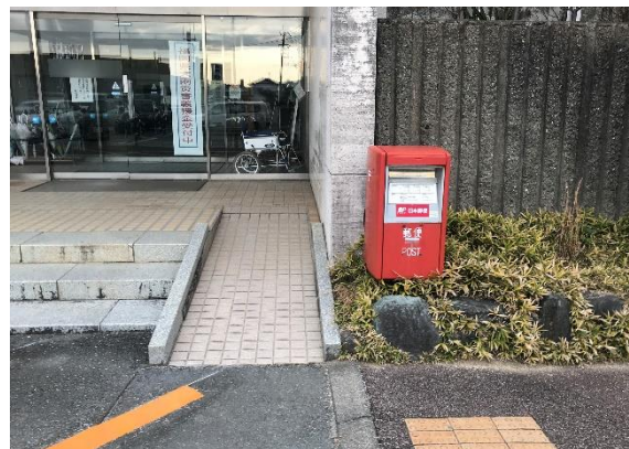
▲スロープのバリアフリー化状況
