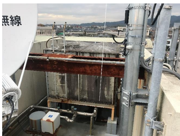
▲受水槽の劣化状況
