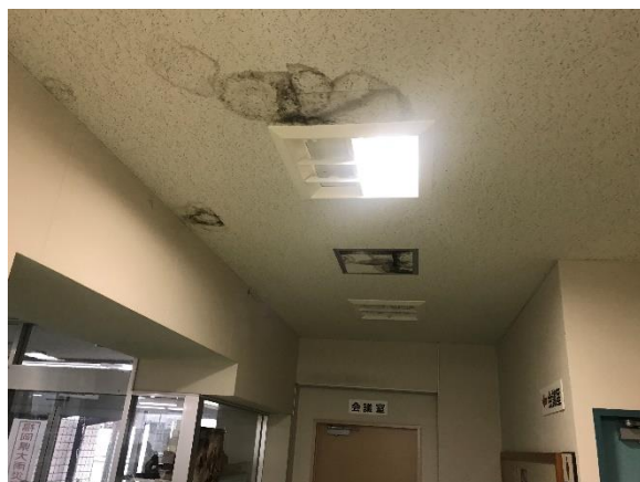
▲天井の雨漏り跡
