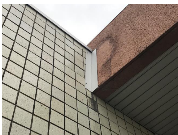
▲外壁のひび割れ補修状況
